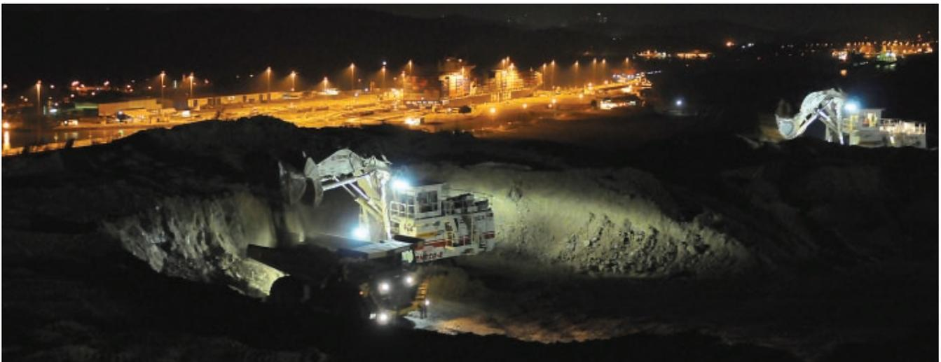
*En diciembre del 2007 comenzaron los trabajos nocturnos de excavación en la cima del cerro Paraíso. La meta es remover 7.4 millones de metros cúbicos de material como parte del primer contrato de excavación seca*
