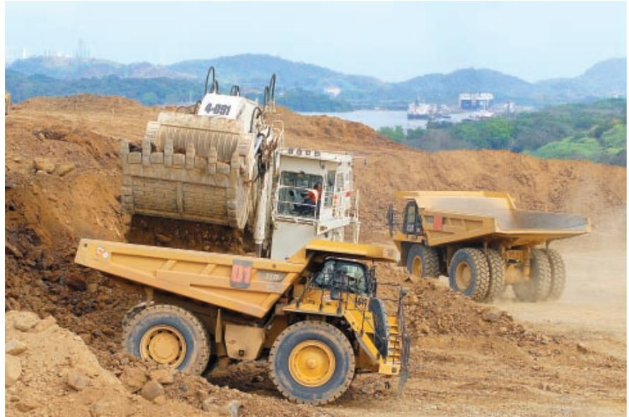
*El Programa de Ampliación del Canal utiliza equipo pesado nunca antes visto en una obra de construcción en el país. Estos nuevos camiones y palas tienen la capacidad para remover la cantidad de material de tierra y roca que se excavarán para la creación del nuevo Cauce de Acceso del Pacífico.*
