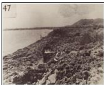
Entre los años 1912 y 1913, se inició un duro proceso de nivelación de terrenos en los que se requirió de grandes rellenos, para luego, a pesar de innumerables obstáculos, levantar esta majestuosa estructura, el Palacio de Bellas Artes.
