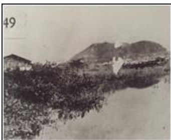
Entre 300 y 400 hombres trabajaron con gran entusiasmo y dedicación, en el proceso de nivelación de los terrenos. Los caminos se construyeron tras la instalación de una moledora de piedra.
